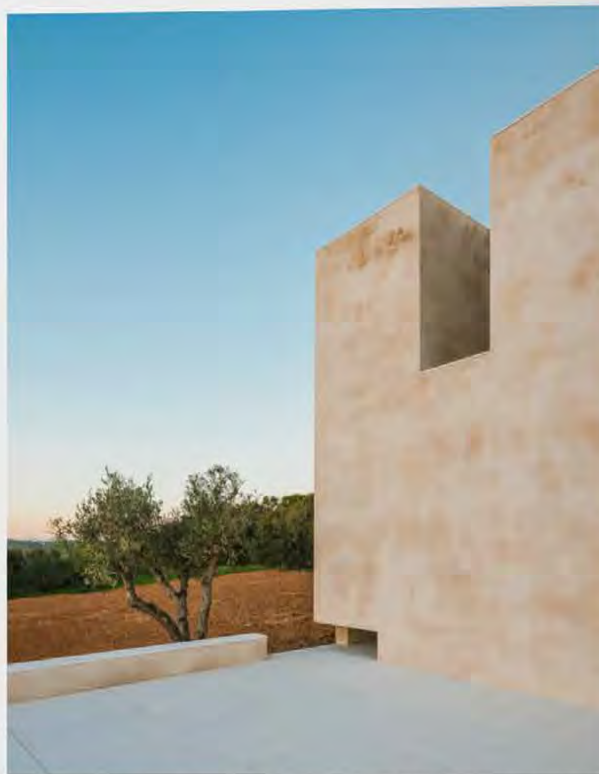
Un dettaglio del fronte principale mette in risalto i due tagli nel volume che permettono a luce ed aria di entrare nell'edificio.
